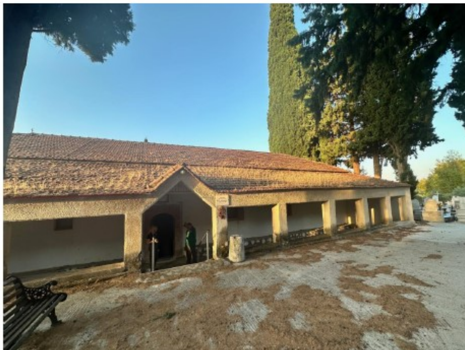
Φώτο 1: Εξωτερική άποψη του κτίσματος ( Νότια όψη)
