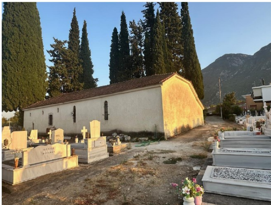
Φώτο 2: Εξωτερική άποψη του κτίσματος ( Βόρεια όψη)
